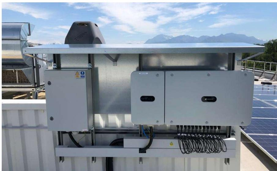
*Onduleur string Huawei en toiture avec boîtier AC. Source : Tecsol*
