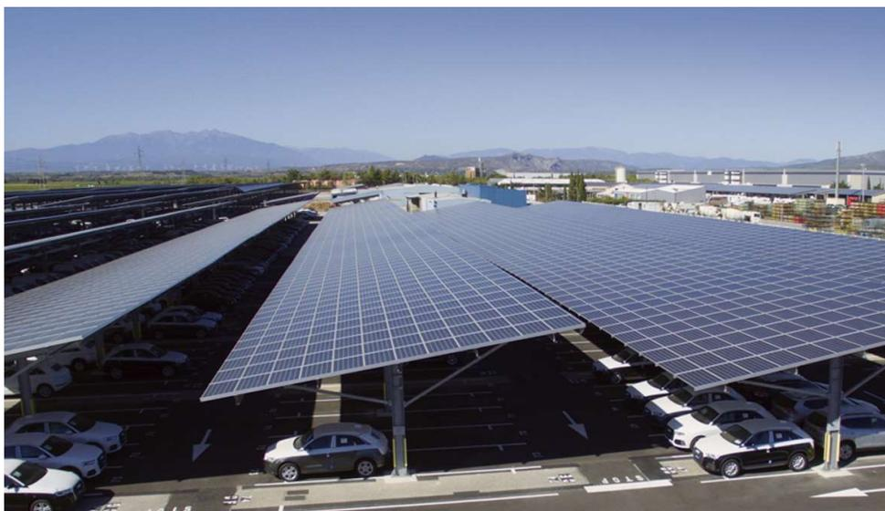
Les ombrières nécessitent la création de fondation (souvent des semelles béton) et donc des travaux de VRD importants. Ces fondations permettent de répondre aux contraintes neige et vent du site. Le béton utilisé est souvent de classe BETON C25/30. Environ 4m<sup>3</sup> de béton sont nécessaires par bloc. Chaque poteau d’ombrière est espacé de 3 places de parking soit 7.5 m.
