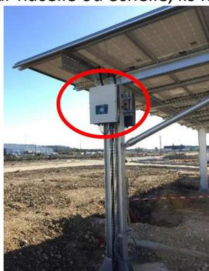
Ainsi, les câbles DC circuleront sous les modules de l’ombrière pour rejoindre l’onduleur.
