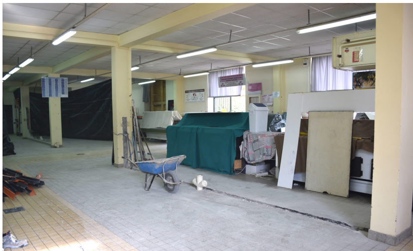
Début des travaux, octobre 2023
